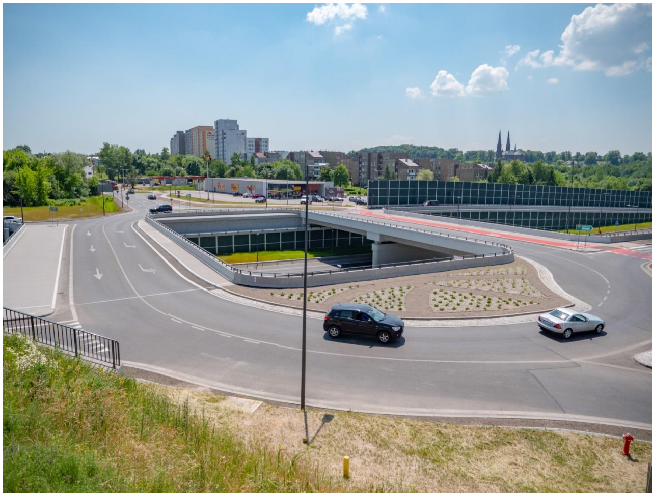
Foto 2 Rondo w ciągu drogi powiatowej ul. Długosza Photo 2 Roundabout on the poviata road (Długosza Str.)
