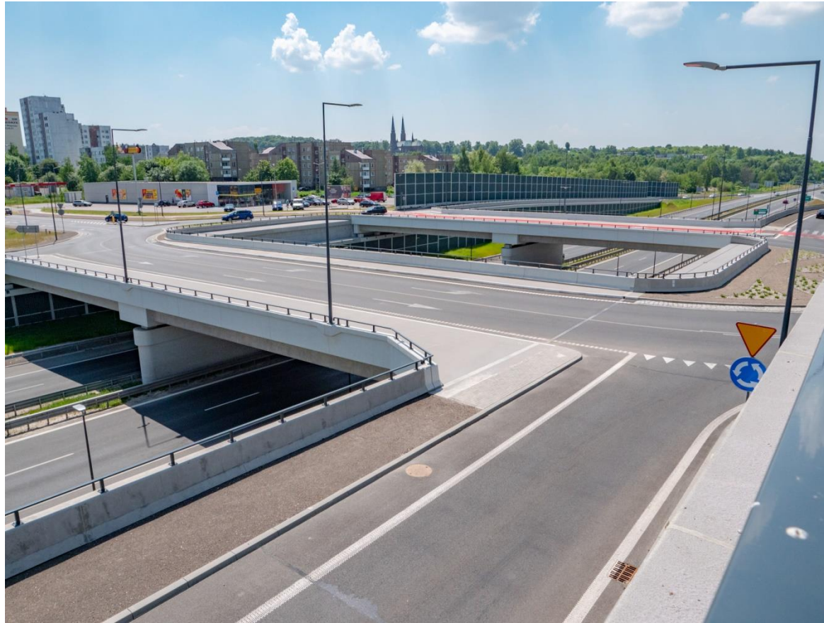
Foto 1 Wiadukt drogowy WD-1 i WD-2 Photo 1 WD-1 and WD-2 bridge
