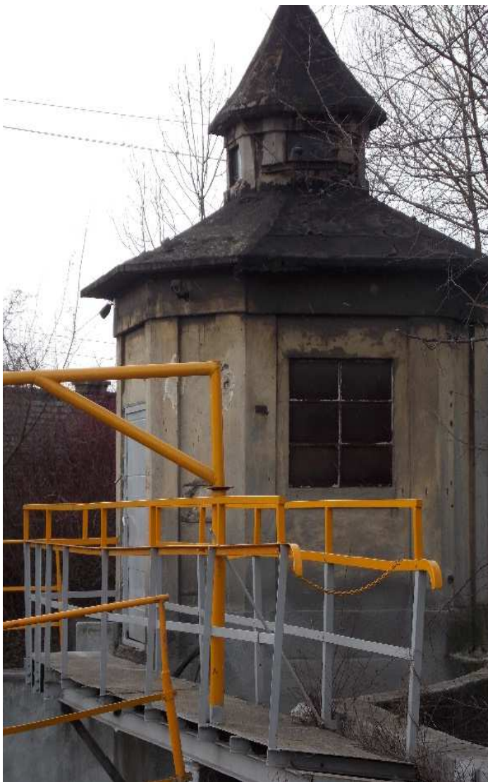
widok przed przebudową
